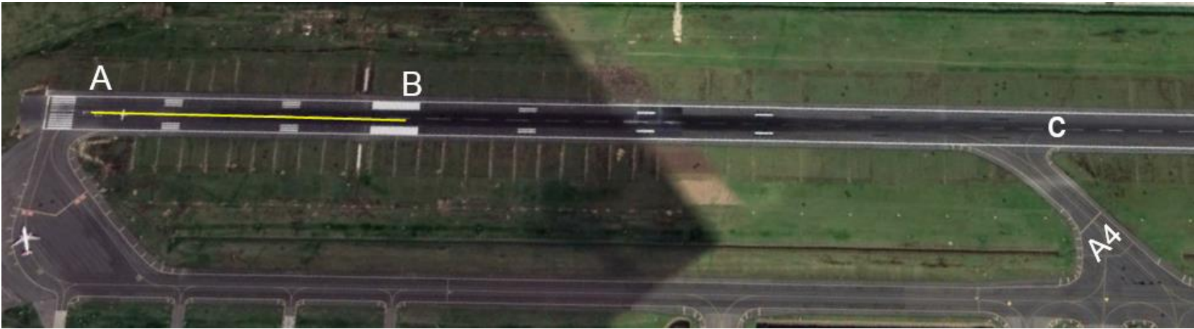
Figura 1. posición de las aeronaves sobre la pista 13L de EDR.
